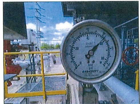
ความดันก๊าซก่อนเข้าอุปกรณ์ปรับลดแรงดัน
